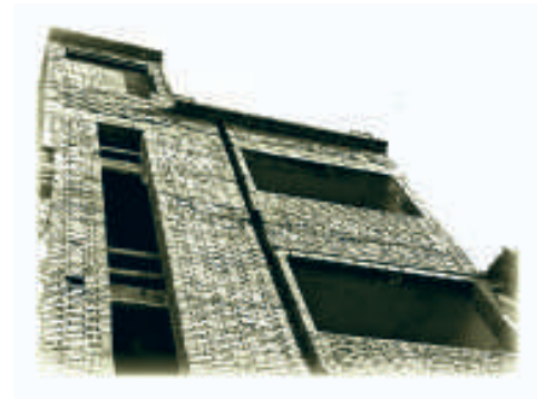
Construcción de la segunda fábrica en la calle Nueva, 27
