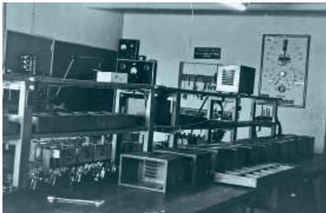
Sala de montaje
